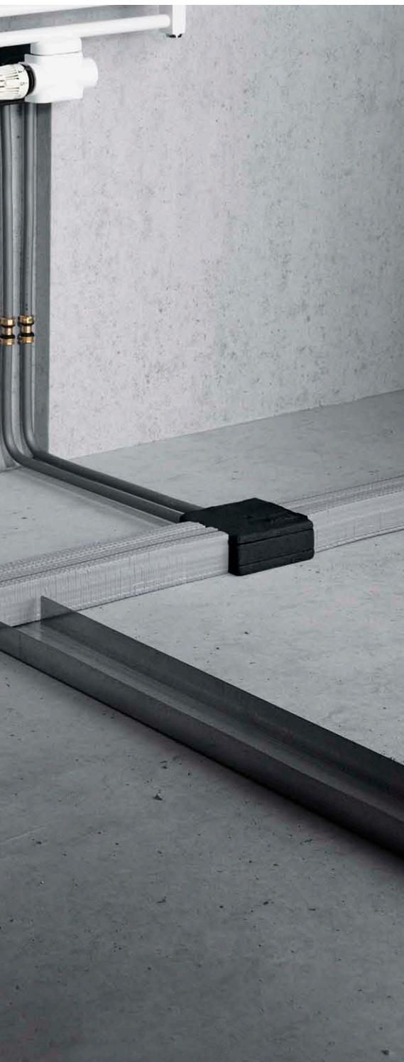
Unabhängig von der Bauform des Anschlussblocks lässt sich unmittelbar nach der Installation die Dichtheitsprobe durchführen. Der Anschluss der Heizkörper erfolgt nach Abschluss aller Putz- und Malerarbeiten.
